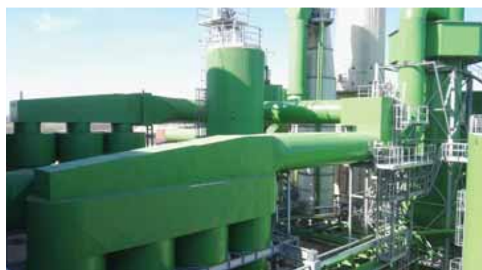
Foto k projektu Zníženie emisií znečisťujúcich látok zo spaľovne odpadov - termovalorizátora, linky kotla K1 (zdroj: KOSIT, a. s.)
