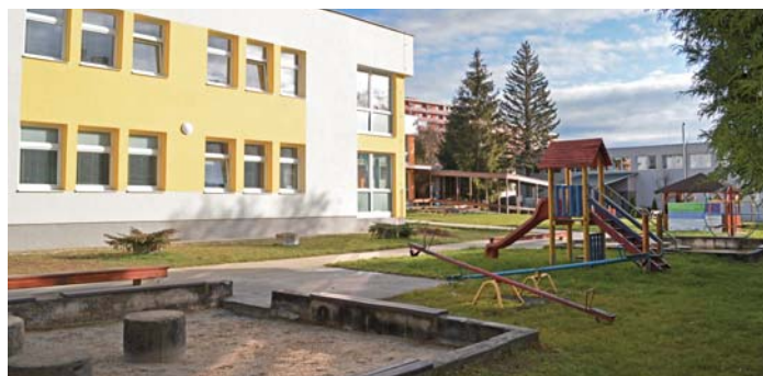
V materských školách v Myjave v rámci obnovy budov vymenili aj staré plynové kotly za tepelné čerpadlá, vďaka čomu sa zásadne znížia aj emisie CO 2
