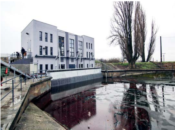
Rekonštrukcia čerpacej stanice Čergov, ktorá chráni pred povodňami mesto Kolárovo. Pôvodná čerpacia stanica bola postavená pred druhou svetovou vojnou a slúžili v nej dieselové motory. Tie boli nahradené modernými, poháňanými elektrinou.
