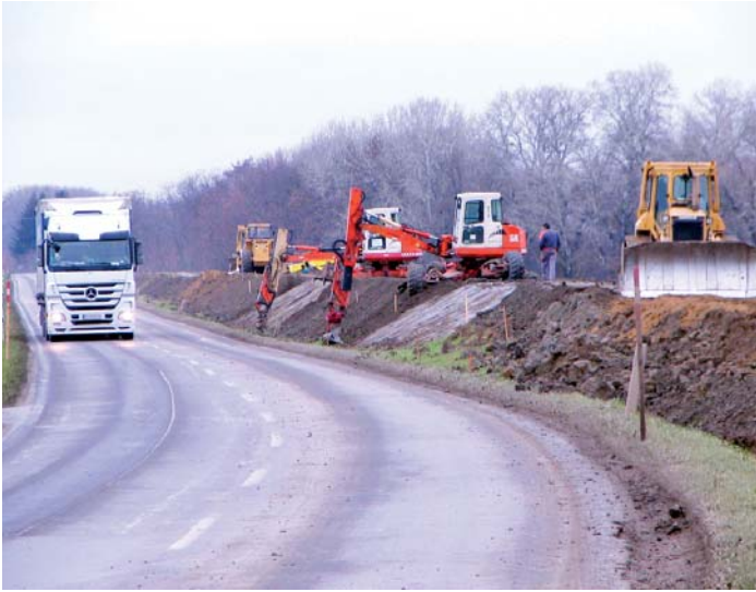
Práce na výstavbe ochrannej hrádze na rieke Čierna voda, Trstice – Kráľov brod. Stavba sa realizovala od roku 2009 do roku 2015 vlastnými kapacitami SVP, š. p.
