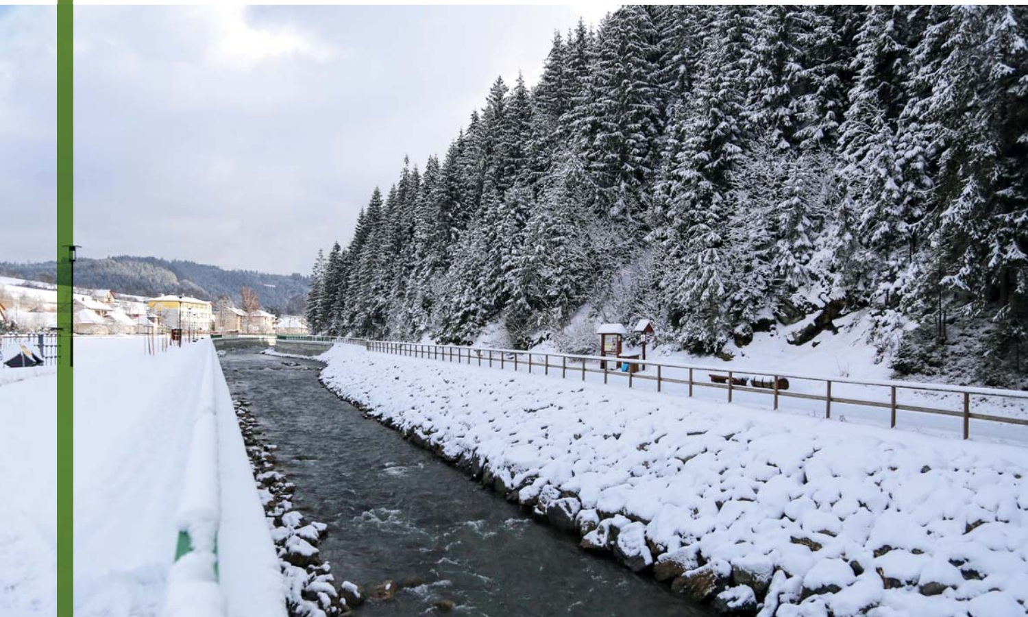
Úprava toku Bystrica v Novej Bystrici. Regulácia koryta a výstavba nových oporných múrov v dĺžke takmer 1 km. Nová Bystrica zažila za posledných 20 rokov povodeň až 8-krát.
