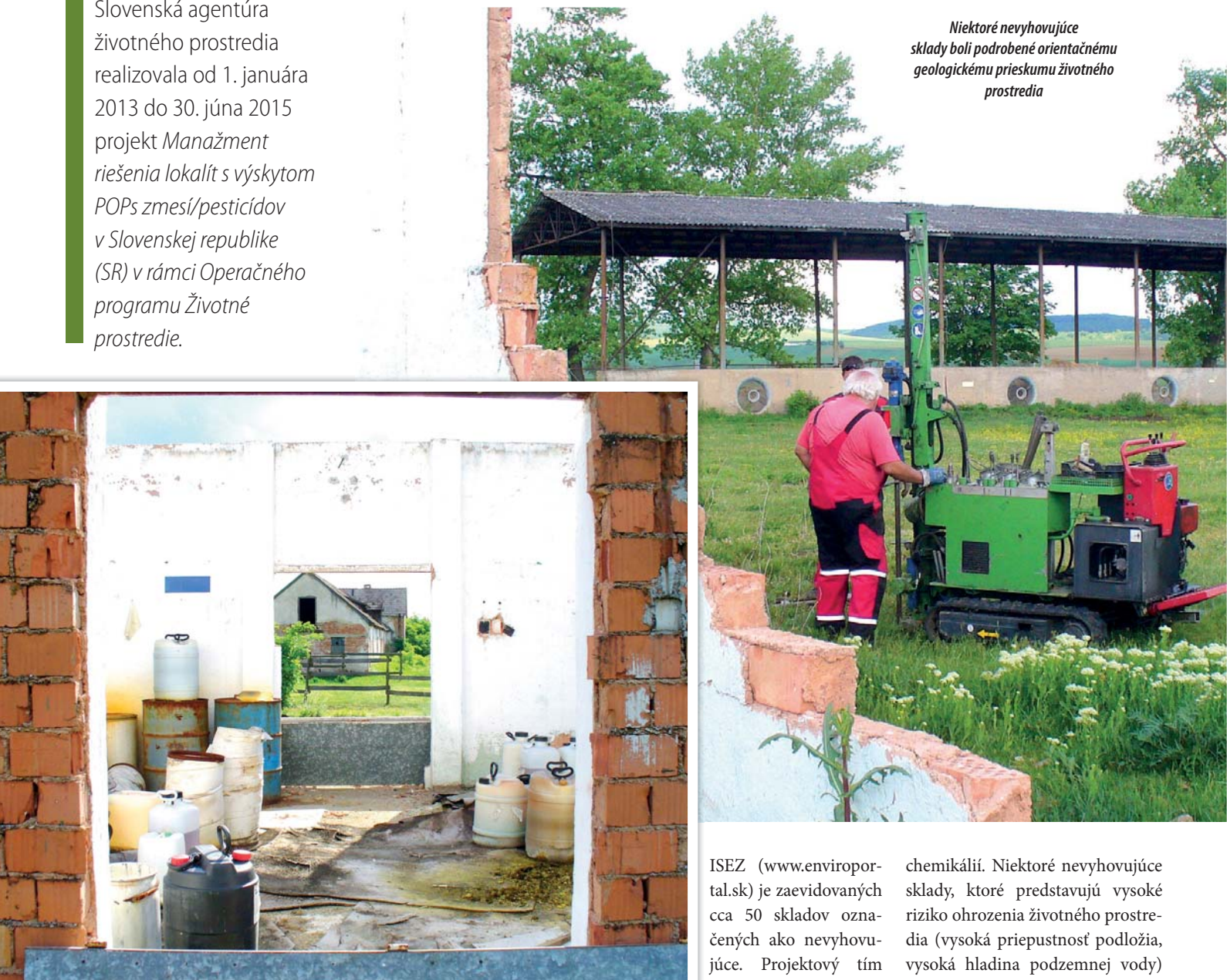
Látky zo skupiny POPs pesticídov sa nachádzajú aj v budovách bez známeho majiteľa, často v dezolátnom stave s priamym vstupom zrážok a splachovaním nebezpečných odpadov do okolia
