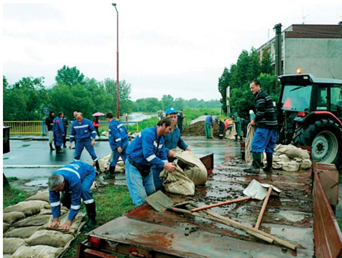
Počas povodne na Iplí v Šahách museli vodohospodári používať ešte klasické vrecovanie
