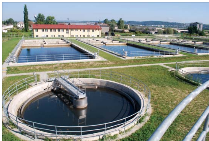
Čistiareň odpadových vôd Vranov nad Topľou
