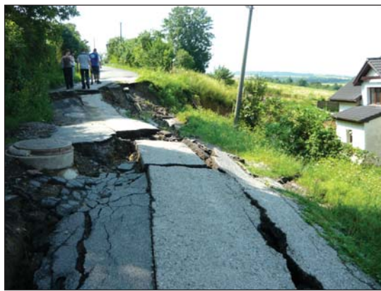
Zosuvom v roku 2010 porušená Obchodná ulica pod kostolom ... a po ukončení sanačných prác na jar 2012 (pohľad zo severu)
