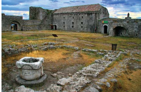
Na hrade Rozafa v Skhodërë/Skadare
