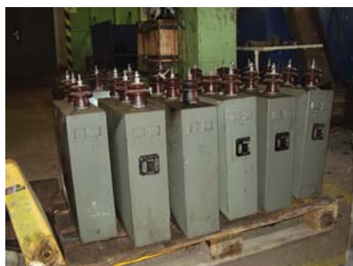
Široká škála kondenzátorov a transformátorov s obsahom nebezpečného PCB
