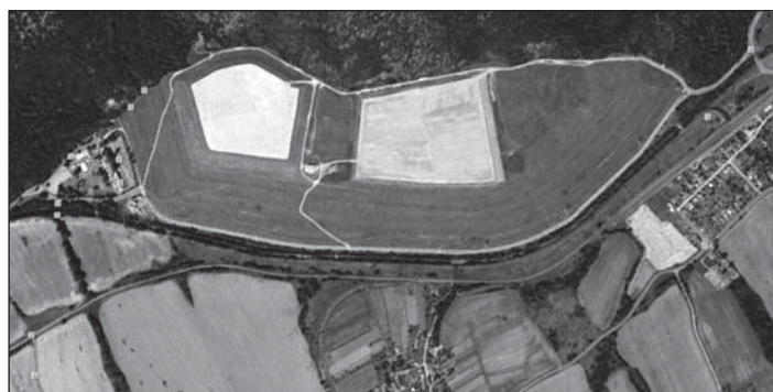
Obr. 3 Bočné (svahové) odkalisko popolového odpadu
