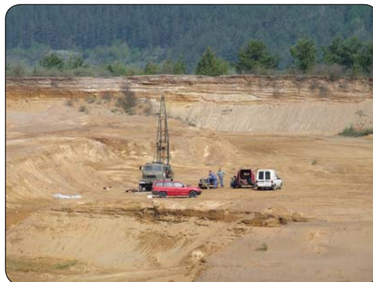
Vrtné práce na odkalisku Rudňany (máj 2010)
