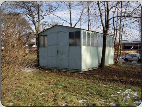
Martin - ZŤS ropná havária, zabezpečený monitorovací vrt
