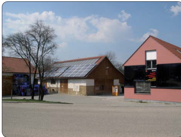
Centrum Veronica v Hostětíne (ČR) – energeticky pasívny dom
