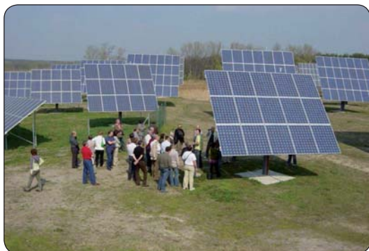
Motoricky natáčaný fotovoltaický systém fotovoltaickej elektrárne v Dubňanoch (ČR)
