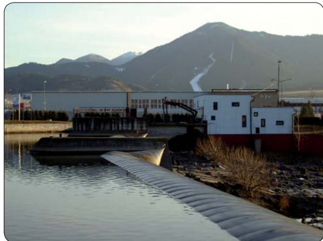
Vodná elektrárňa na Váhu
