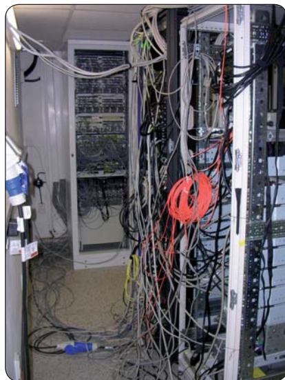
Pohľad do miestnosti serverov – zľava doprava: diskové pole, zopár serverov, v pozadí switche, routre a optický kábel, ktorým sa pripája SAŽP a ŽPNeT cez sieť SANET2 do internetu
