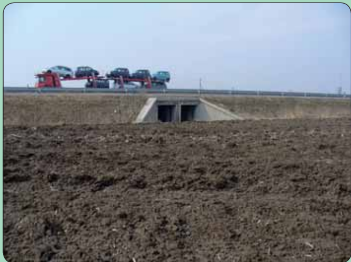
Dva tunelové podchody v katastri obce Čunovo pre voľne žijúce živočchy
