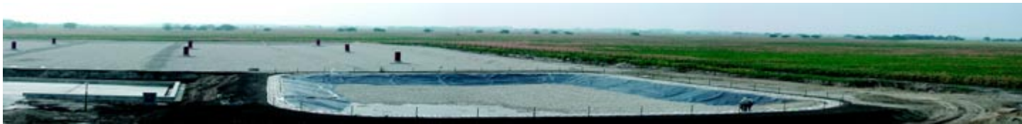
Panoramatický pohľad na budovanie skládky odpadov v prvej etape
