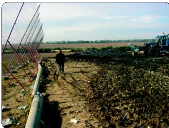
Vpravo prekrývanie a hutnenie uloženého odpadu, vľavo prenosná záchytná sieť proti úletom odpadu do okolia skládky odpadov
