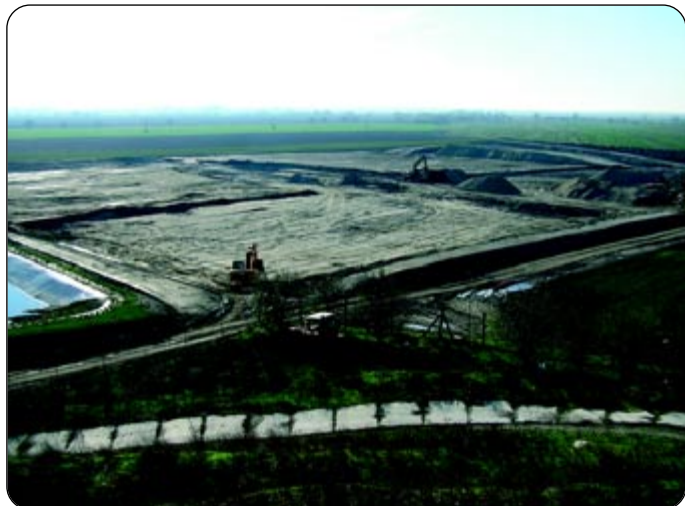
Zemné práce v rámci druhej etapy výstavby skládky odpadovného povolenia.
