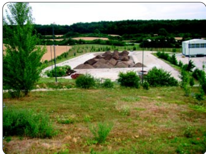
Na niektorých skládkach odpadov sa budujú kompostovacie zariadenia
