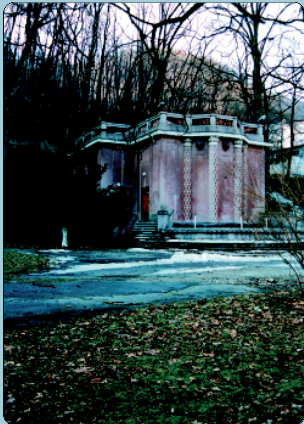
Budova bývalej MVE Trenčianske Teplice
