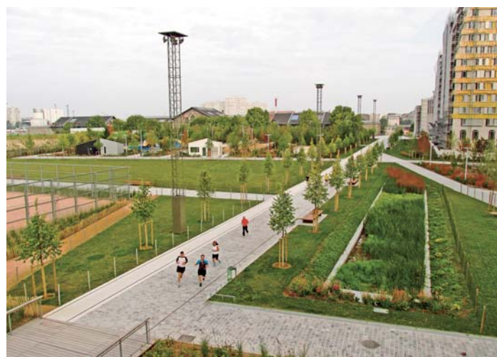
Retenčné prvky na zrážkovú vodu s vodnými a vlhkomilnými rastlinami sú nielen funkčným, ale aj atraktívnym prvkom verejných priestorov a plôch zelene v sídlach (Park Martina Luthera Kinga, Clichy – Batignolles, Paríž, Francúzsko)
