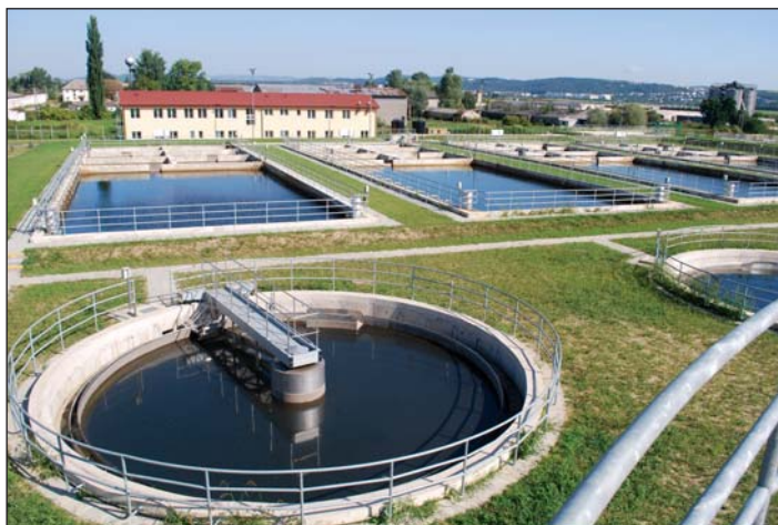
Čistiareň odpadových vôd Vranov nad Topľou
