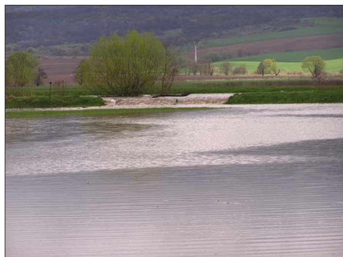
Prelítanie ochranej hrádze na toku Slaná pri povodni v roku 2010
