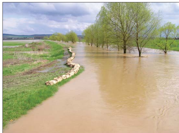
Zabezpečovacie práce počas povodňovej aktivity na toku Slaná v r. 2010
