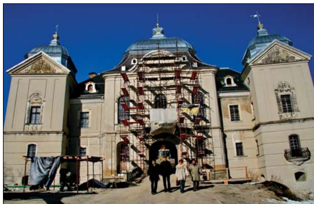
Obnova Haličského zámku
