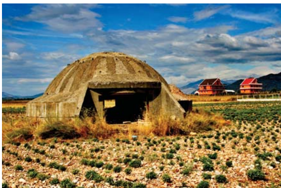
Jeden z desaťtisícov opustených bunkrov na vidieku
