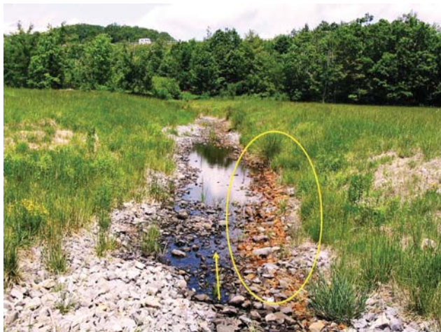
Neutralizácia kyslej banskej vody prostredníctvom vápencových úlomkov v prostredí otvorených kanálov. V okrajových častiach kanálu možno pozorovať vyzrážané sekundárne minerály (červené povlaky). Žltá šípka znázorňuje smer prúdenia vody
