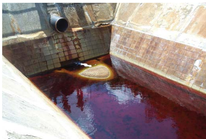
Drenáž na zachytávanie silno kyslej vody z kremencového lomu v Sobove
