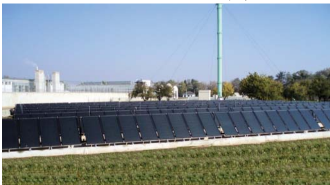
Najväčší solárny termický systém na Slovensku v Želiezovciach ušetrí ročne 60 % z celkového množstva spotrebúvaného zemného plynu na prípravu teplej vody vykurovaného objektu, čo predstavuje aj významné zníženie emisií CO 2
