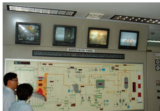
Bucheon Waste Disposal Center (riadiace centrum a panel s aktuálnym stavom vypúšťaných emisií) denne zhodnotí spaľovaním približne 300 t komunálneho odpadu, recyklované druhy zariadení (150 t), potravinové zvyšky (240 t), nadrozmerný odpad (50 t).
