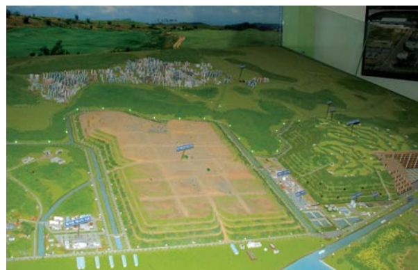
Skládka odpadu Sudokwon (maketa) s rozlohou 20 mil. m 2 patrí medzi najväčšiu a najčistejšiu skládku, kde sa denne privezie 18 000 ton odpadu. Odpad sa „premieňa“ na energiu využitím kalov a bioplynu. Do roku 2020 by sa skládka mala stať „Metropolitan Eco and Energy Town“, s ročnou produkciou 2,61 mil. G kcal.
