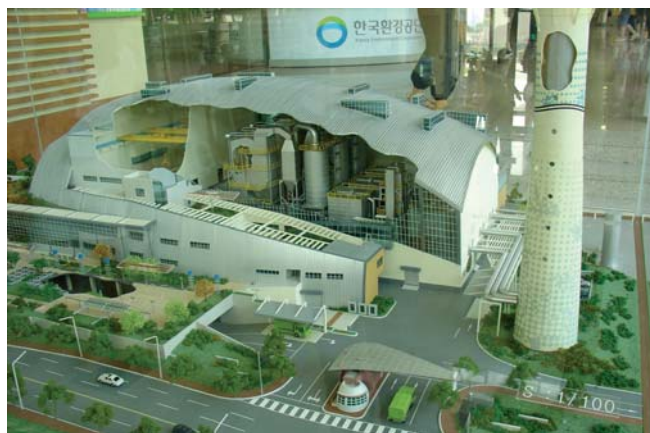
Bucheon Waste Disposal Center (riadiace centrum a panel s aktuálnym stavom vypúšťaných emisií) denne zhodnotí spaľovaním približne 300 t komunálneho odpadu, recyklované druhy zariadení (150 t), potravinové zvyšky (240 t), nadrozmerný odpad (50 t).
