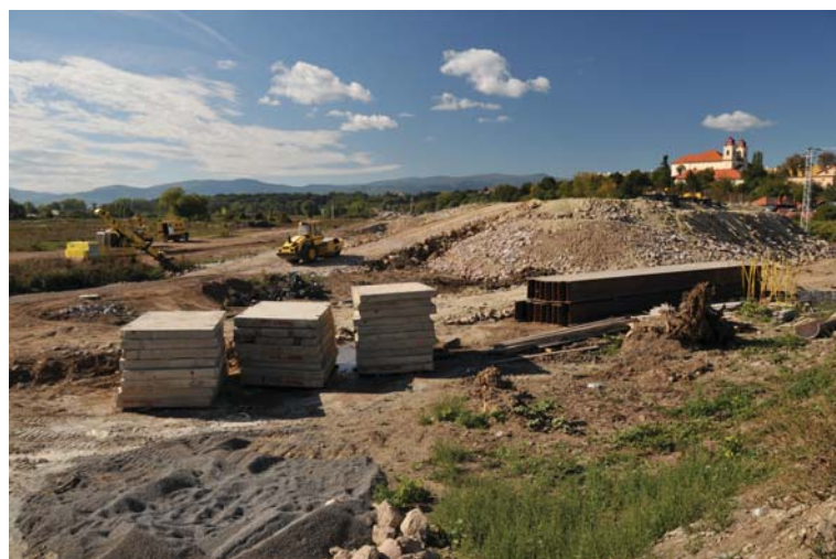
Výstavba rýchlostnej komunikácie Žiar nad Hronom
