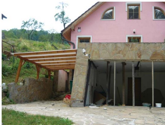
Zdeformované múry suterénu rodinného domu na Horárskej ulici v Prešove po zosuve v júni 2010 znemožnili uzavretie objektu garážovými dverami
