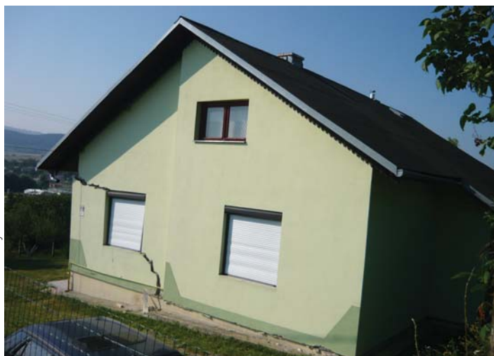
Svahové zosuvy v júni 2010 narušili statiku rodinných domov (na snímke rodinný dom v Kapušanoch)
