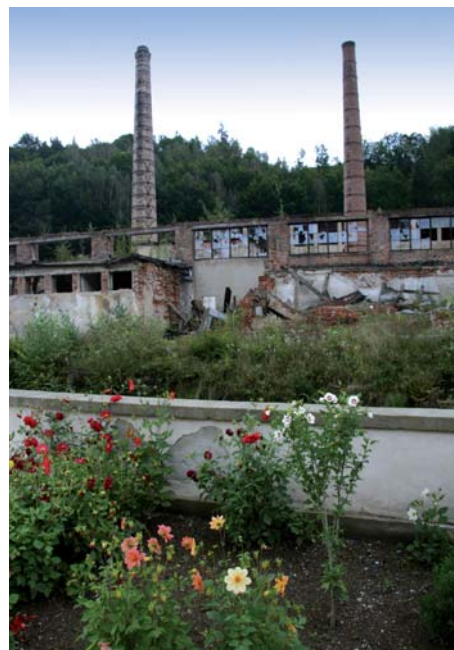
Neduhy environmentu (na snímke bývalé sklárne Utekáč)
