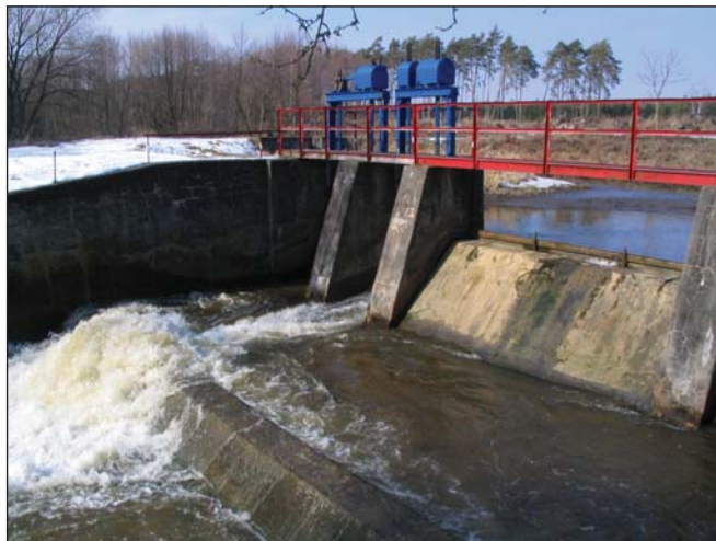
Vodohospodársky objekt na rieke Rudave
