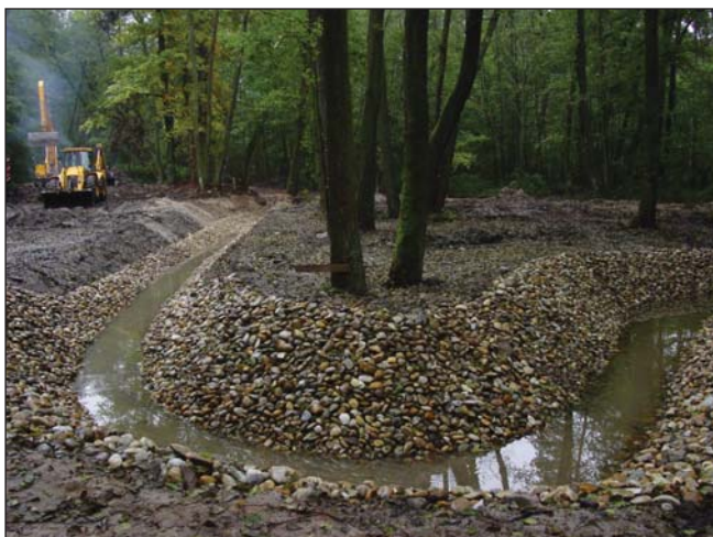
Vybudovaný rybovod na rieke Rudave
