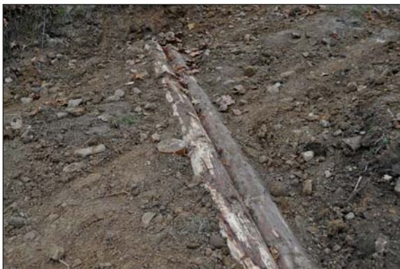
Odrážky na lesnej ceste v Starej Bystrici
