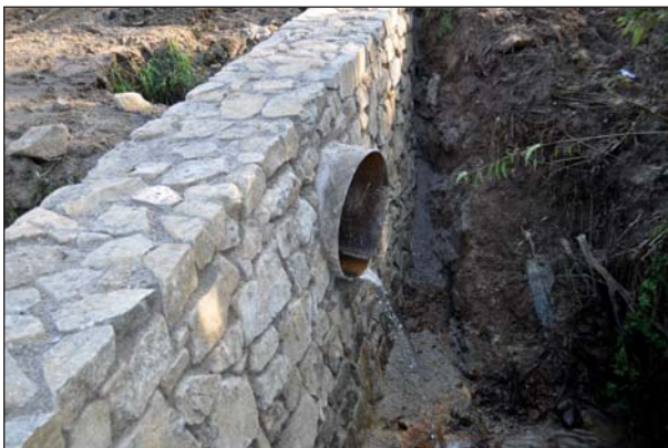
Protipovodňová nádrž s prepadom na Minarickom potoku na hranici intravilánu a extravilánu obce Stará Bystrica
