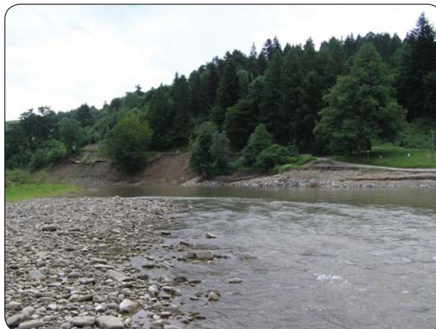
Rieka Poprad v hraničnom úseku s Poľskom poniže Mníška nad Popradom ešte čaká na sanáciu. Povodeň odtrhla časť cesty do obce, prehĺbila a rozšírila koryto rieky až tak, že sa hraničná čiara s Poľskom posunula na naše územie
