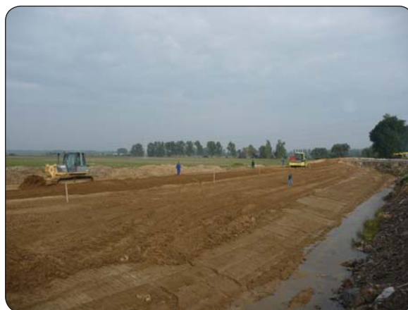
Sanácia pravobrežnej hrádze Ondavy - zemina sa musí rozhrňať a valcovať po 20 cm vrstvách
