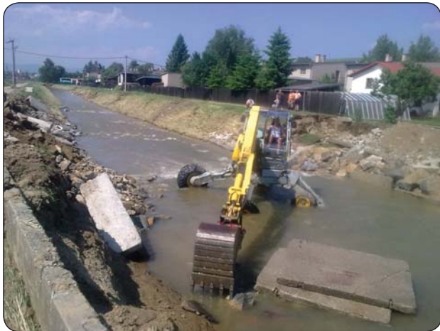
Pri úprave takmer štvorkilometrového koryta Ľubického potoka v Kežmarku - Ľubici musel byť nasadený aj tzv. kráčajúci bager
