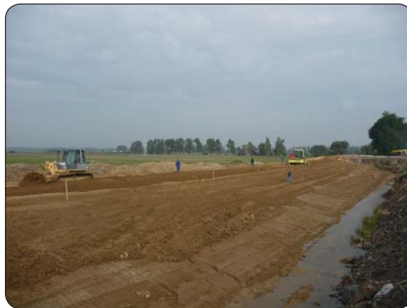
Sanácia pravobrežnej hrádze Ondavy - zemina sa musí rozhrňať a valcovať po 20 cm vrstvách
