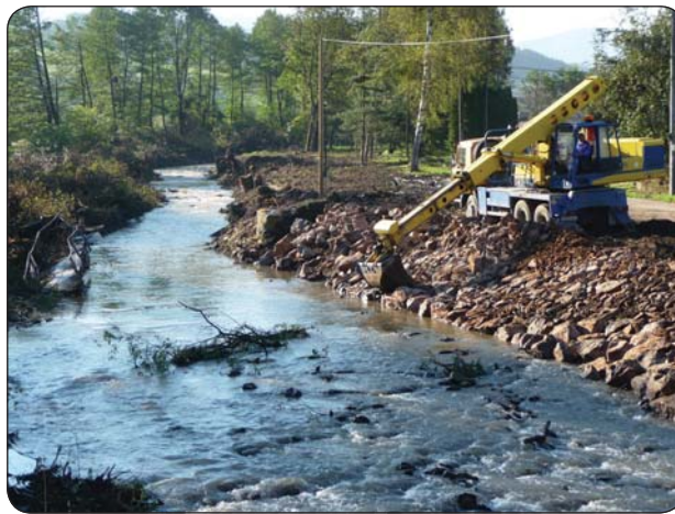
Bagrista Ladislav Tóth zo závodu Dunaj Bratislava uvoľňuje zátarasy a nánosy v koryte rieky Handlovky a spevňuje brehovú líniu
