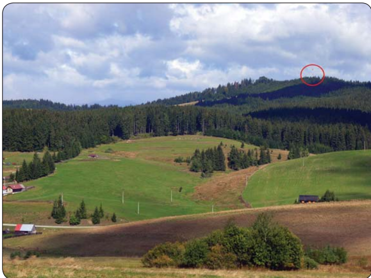
Oblasť Pol'any – dohľadované územie s vyznačením stĺpa mobilného operátora, na ktorom je umiestnená kamera
