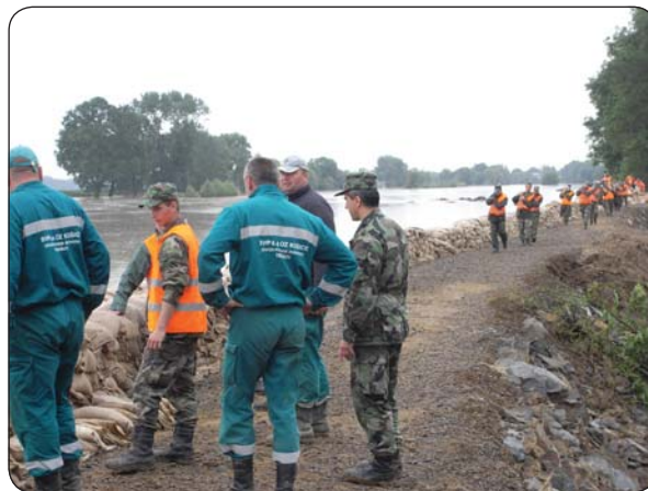
Vrečovanie pravobrežnej hrádze Ondavy (foto: archív SVP)
