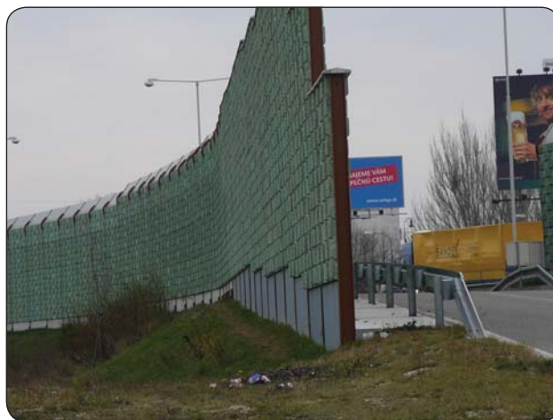
Protihluková stena na diaľničnom privádzajú Mierová ul. - Senecká ul. v Bratislave po viacnásobnej rekonštrukcii
