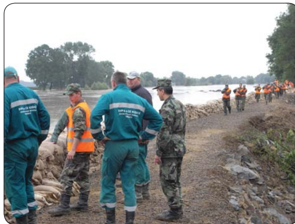
Vrecovanie pravobrežnej hrázde Ondavy (foto: archív SVP)
