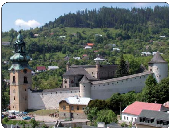
V prípade schválenia nenávratného finančného príspevku z Regionálneho operačného programu bude na Starom zámku zrekonštruované podkrovia a rozšíri sa expozičná časť (foto: Katarína Patschová)
