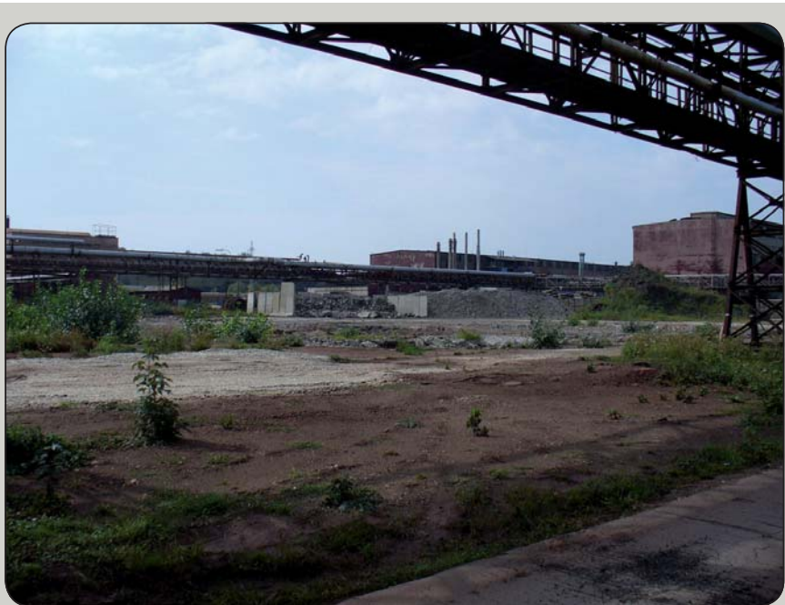
Sereď - Niklová huta - areál bývalého podniku, červený prach v areáli
