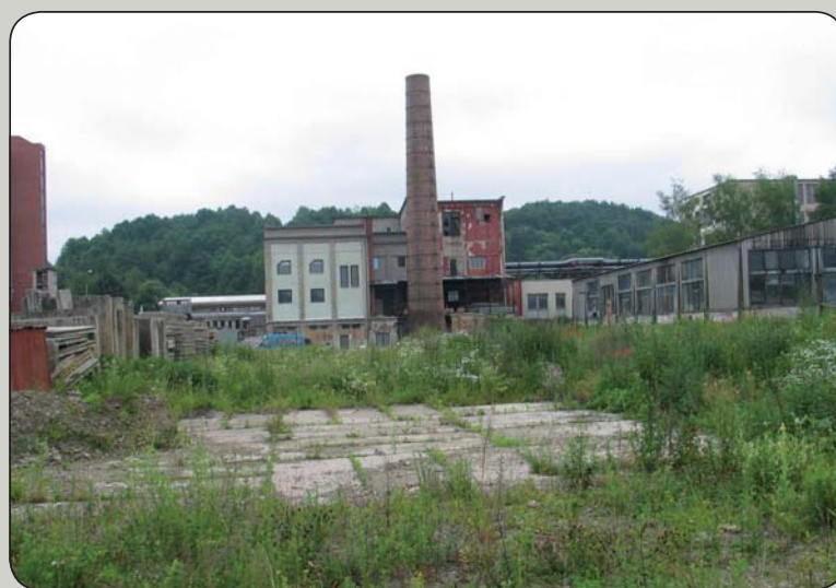
Bardejov - areál podniku JAS, kotolňa a bývalé opravárenské dielne
