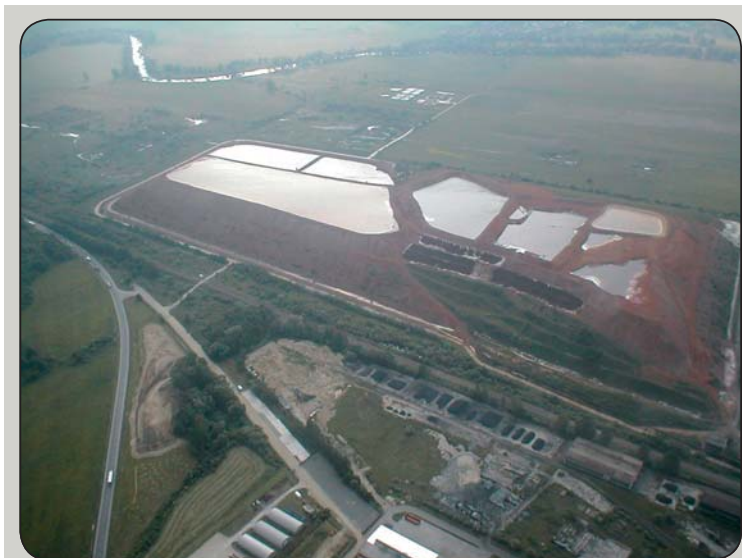
Odkalisko kalové pole v pôvodnom stave (2001)
