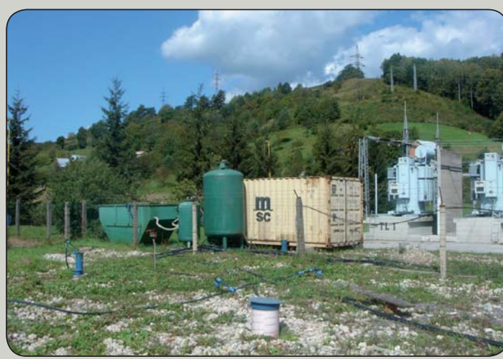
Bardejov - prebiehajúca sanácia v okolí areálu elektrickej stanice
