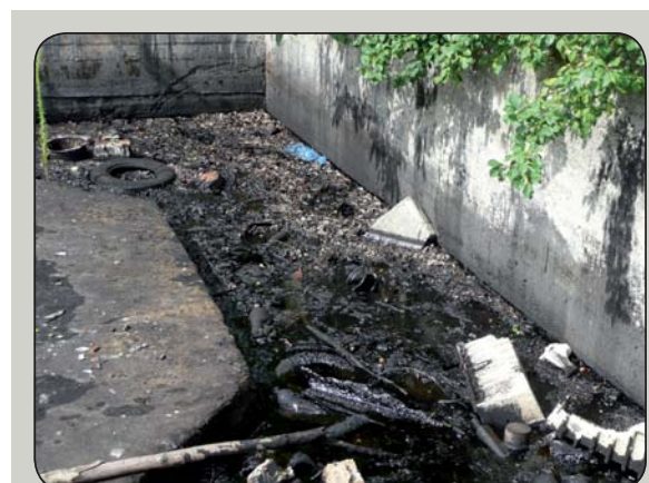
Semerovo - areál bývalej tehelne, pohľad na ropné látky v pravdepodobnom úložisku nádrží
