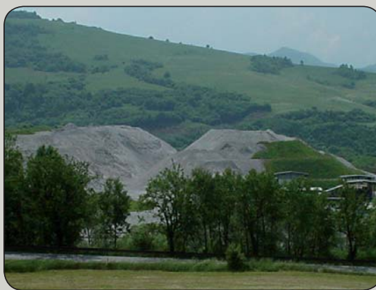
Istebné - OFZ - halda trosky Skládka trosky z výroby ferozliatín Oravských ferozliatinárskych závodov v Istebnom je budovaná takmer 50 rokov a tomu zodpovedá aj množstvo skládkovaného materiálu. Objekt sa nachádza priamo vo výrobnom areáli a v jeho okolí je vybudovaný monitorovací systém. Monitoring bol uskutočňovaný za účelom overenia vplyvu skládky trosky z výroby ferozliatín, resp. samotného areálu závodu na širšie okolie. Doterajšie chemické analýzy jednoznačne potvrdili výskyt vysokých koncentrácií Cr, Cr 6+ a Mo a ďalších ťažkých kovov, ako aj amónnych iónov a silne alkalickú reakciu vody v pozorovacích objektoch. Podľa máp vhodnosti pre skládky odpadu ide o oblasť s vysokým ohrozením podzemnej vody.
