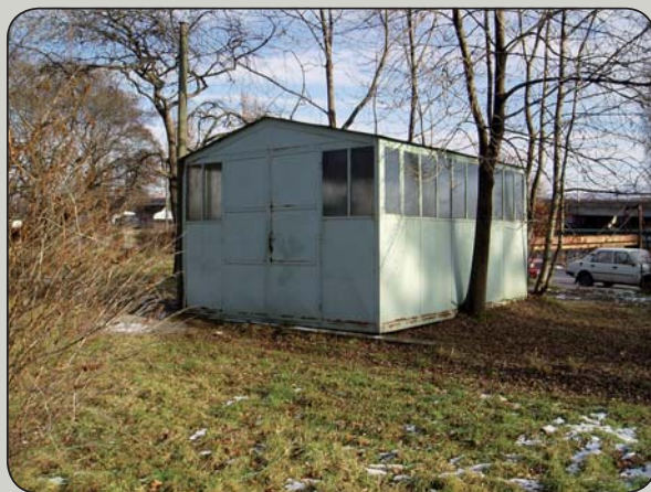
Martin - ZŤS ropná havária, zabezpečený monitorovací vrt
