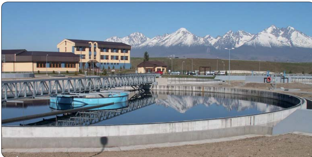
Moderná čistiareň odpadových vôd v Poprade
