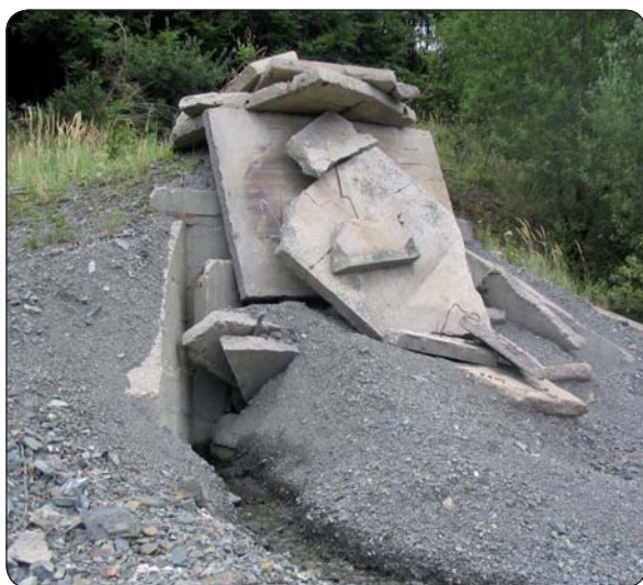
Opustená baňa Pezínok-Trojárová. Kvôli zabráneniu vstupu do štólne je vchod zatarasený betónovými panelmi. Zo štólne neustále vyteká banská voda so zvýšeným obsahom Sb, As a Fe
