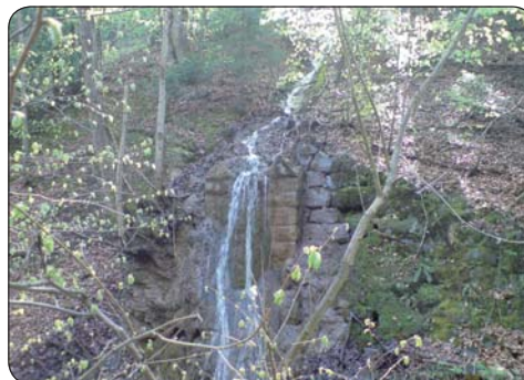
Malý vodopád prepádovej vody z tunela
