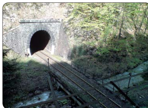
Tunel prerušený dolinou
