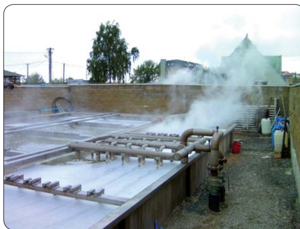
Geotermálny výmenník tepla
