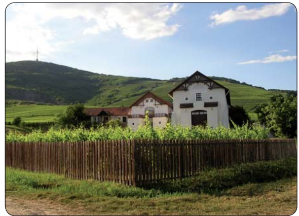
Obnova muštárni pri mestečku Tokaj
