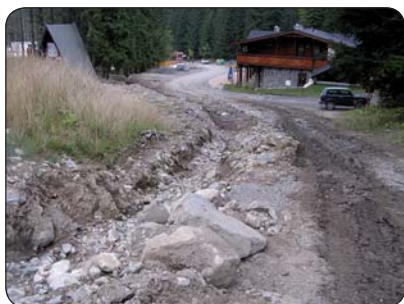
Obr. 1: Rýchová erózia na lesnej ceste spôsobená častými prejazdmi ťažkej stavebnej mechanizácie
