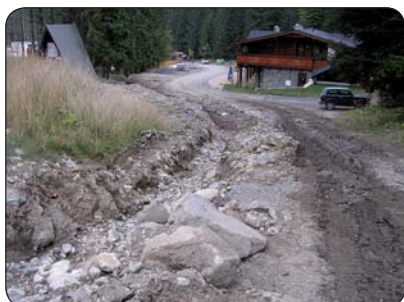
Obr. 1: Rýchlová erózia na lesnej ceste spôsobená častými prejazdmi ťažkej stavebnej mechanizácie
