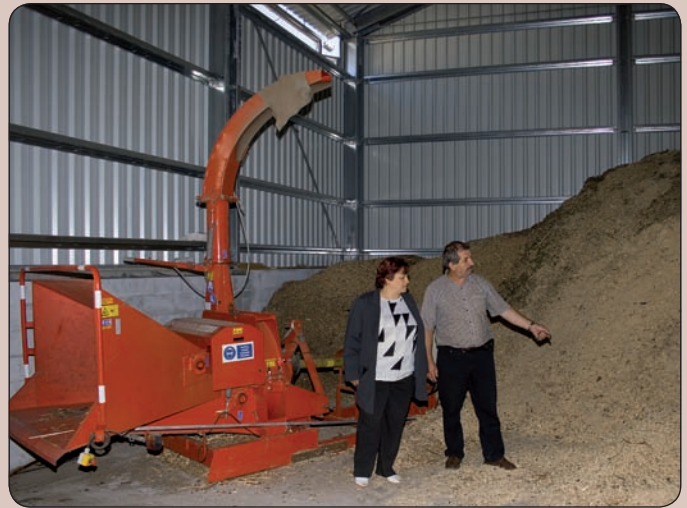
Kotloňa so spaľovaním biomasy v Strečne (foto: archív SAŽP)
