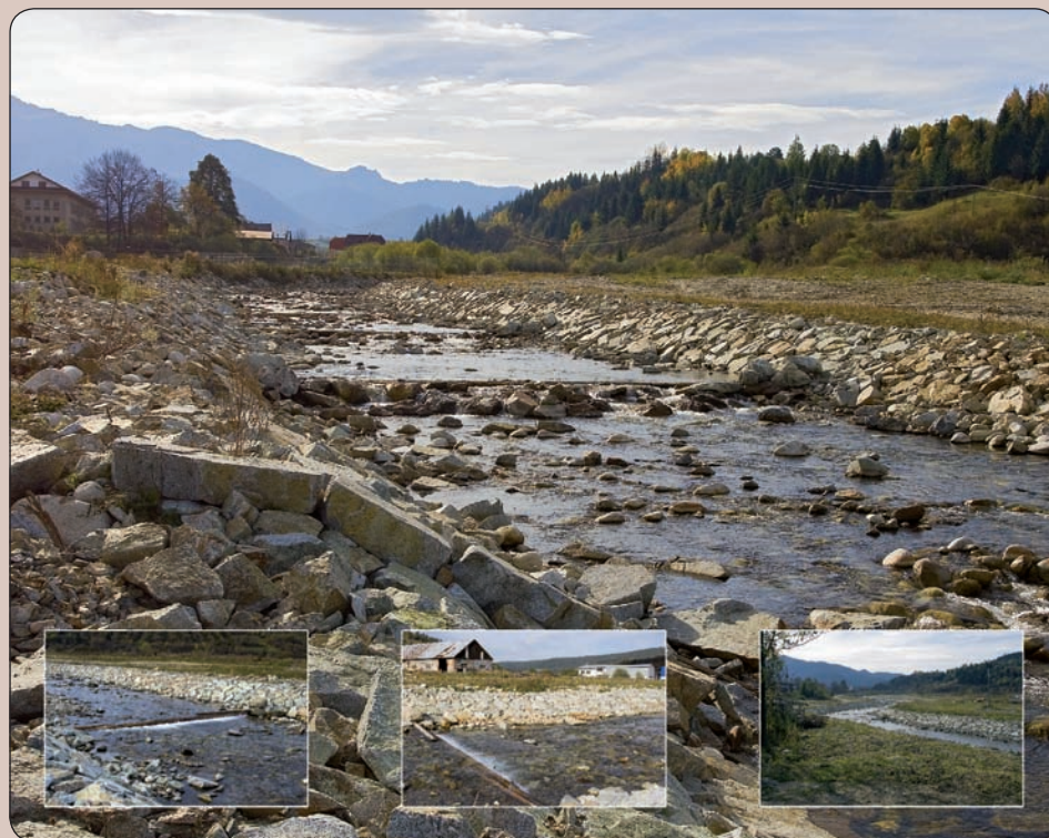
Stabilizácia koryta Studeného potoka v Habovke pomocou EÚ (foto: archív SAŽP)
