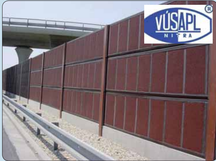
Protihlukový prvok vyrobený z recyklovaných autoplášťov je realizačným výstupom projektu VÚSAPL, a. s., Nitra. Jeho akustické parametre ho pri správnom zabudovaní predurčujú na odhlučnenie priestorov s nadmernou hladinou hluku.
