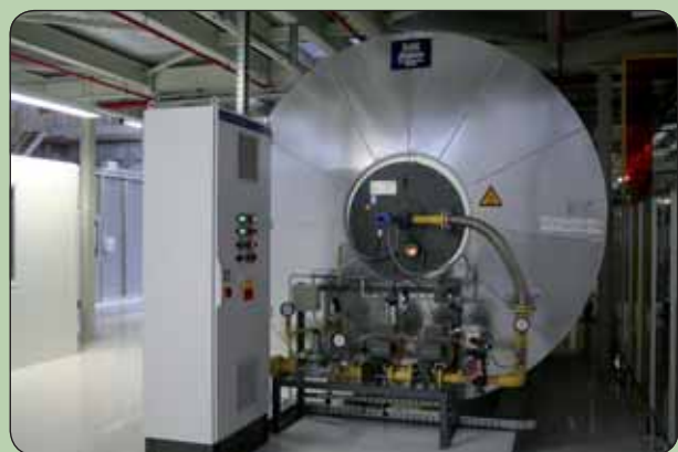
Termické odľučovacie zariadenie
