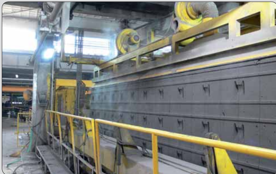
Obr. 1 Pohľad do výrobného závodu firmy PORFIX - pórabetón, a. s., Zemiarské Kostolány pri výrobe murovacích tvárnic z pórabetónu na báze elektrárenského popolčeka. Firma získala certifikát SAŽP potvrdzujúci splnenie požiadaviek normy STN EN ISO 14024 pre výroby PORFIX
