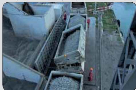
Obr. 2 Prísun vyťaženej a podrovej odpadovej horniny k výrobe betónu pre ostenie tunela Amsteg
