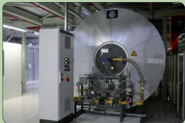
Termické odľučovacie zariadenie
