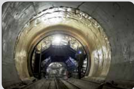
Obr. 3 Využitie vlastnej odpadovej horniny pri výstavbe ostenia alpského tunela Amsteg
